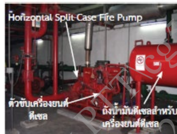
การขับเคลื่อนเครื่องสูบน้ำดับเพลิงด้วยเครื่องยนต์ดีเซล และมอเตอร์ไฟฟ้า
